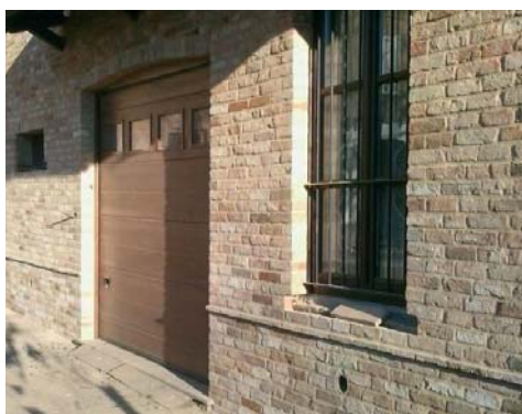
Applicazione di MFV10 Color per la realizzazione di murature faccia a vista.
