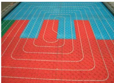
Con CT20 è possibile realizzare pavimentazioni riscaldanti/raffrescanti mediante l'inserimento al suo interno di "serpentine" radianti.
