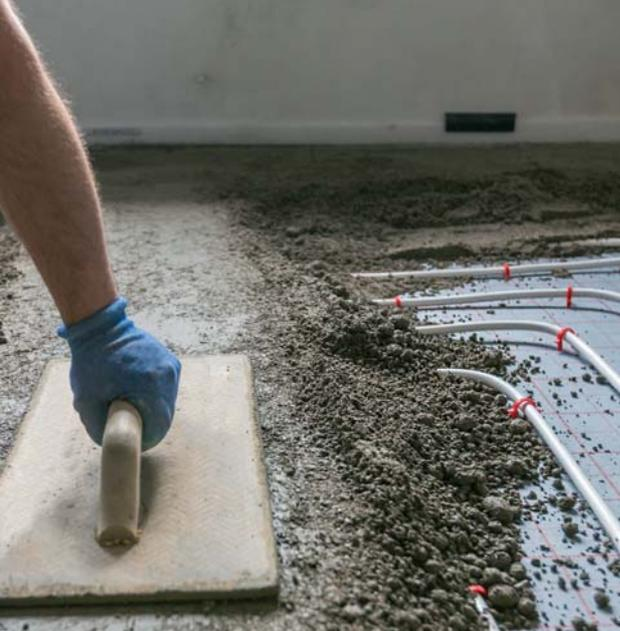
Le fibre migliorano le prestazioni del massetto in termini di resistenza e flessione ed evitano la formazione di microfessurazioni.
