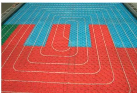
Con CT25 FIBERPLUS è possibile realizzare pavimentazioni riscaldanti/raffrescanti mediante l'inserimento al suo interno di "serpentine" radianti.
