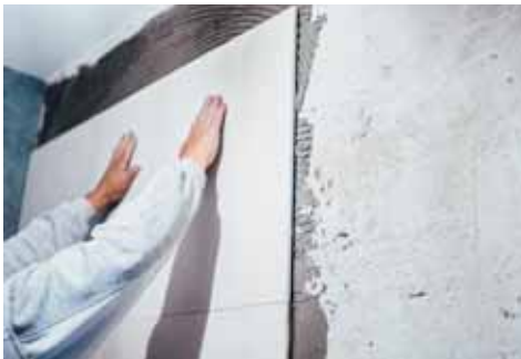
Posa di grandi formati a parete con adesivo cementizio grigio. A scivolamento verticale nullo, permette la posa a parete senza l'utilizzo di distanziatori
