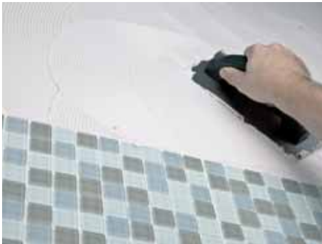
Posa a parete di mosaico vetroso con adesivo cementizio bianco.
