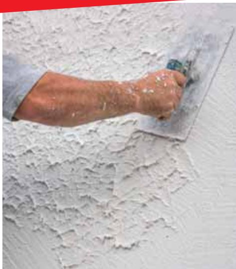
Applicare il prodotto in due mani incrociate con lama d'acciaio e finire con frattazzo di spugna.
